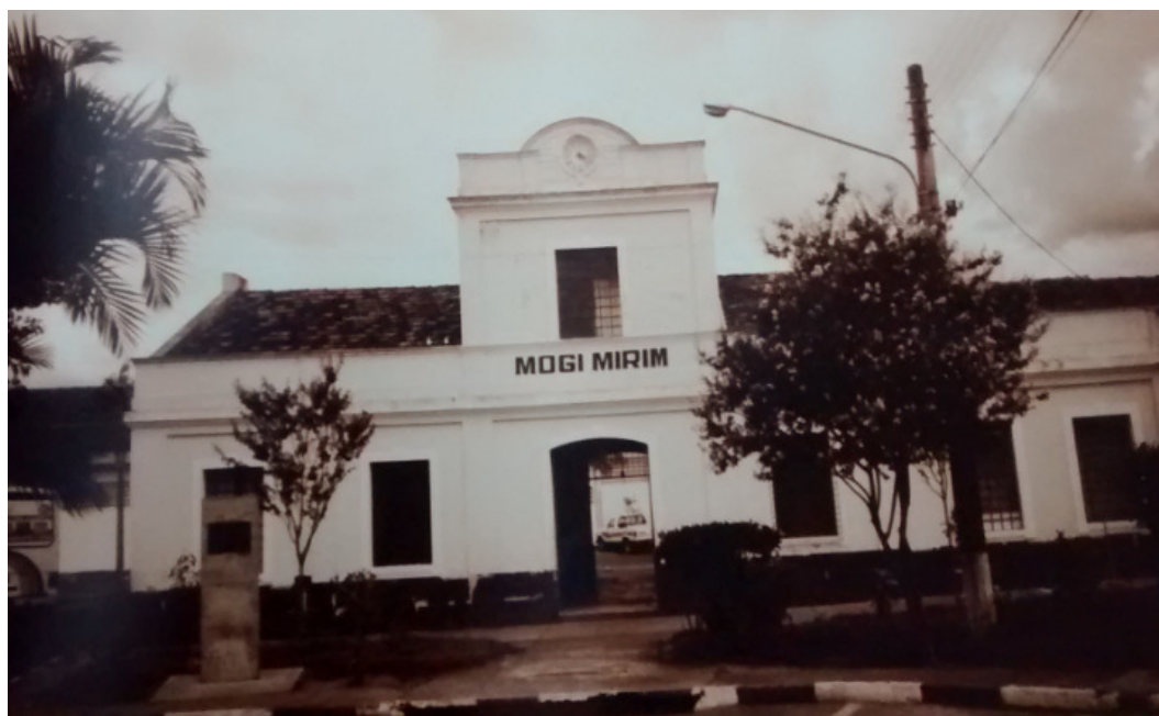
Figura 1- Estação Ferroviária de Mogi Mirim, s. d. Fonte: Desconhecida
